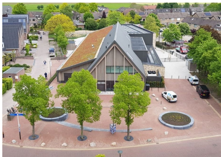
Afbeelding 2.1: Het nieuwe Multifunctioneel Centrum 'Den Hoek' in Hoogblokland met groen dak.
